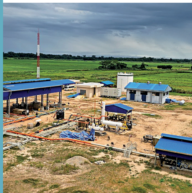
Batería de Compresión Campos Menores
